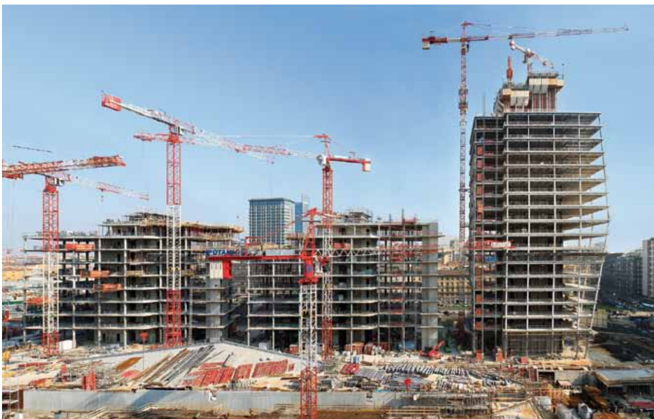
Vista del lotto 1: sulla destra la Torre Diamante, che sarà alta ben 140 metri
