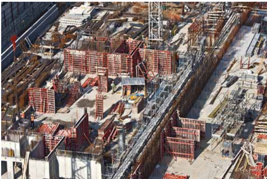
Lotto 2: utilizzo in cantiere di Trio per la realizzazione delle pareti in c.a.
